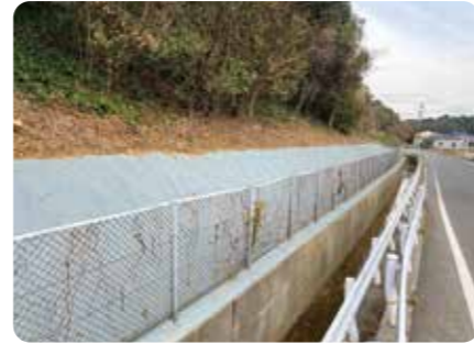
盛土のり尻部(九州道 北九州)
