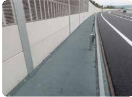
本線路肩(九州道 熊本)
