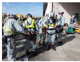
③現場パトロール
